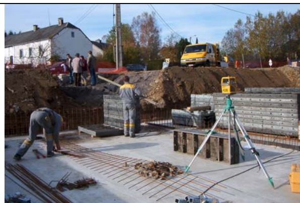
Le fond est bétonné. Pose des coffrages des parois
