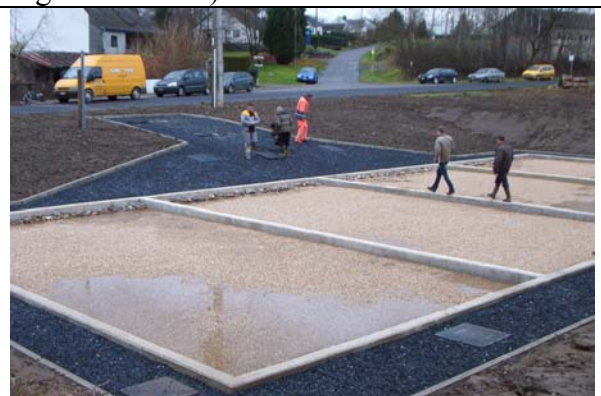
Vue d'ensemble des 4 cellules (6,2 m x 11 m) avant plantation (prévue en avril 2007).
