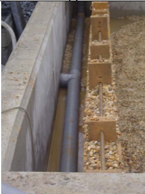
Le 'drain' de sortie est posé. Dépôt des couches de graviers
