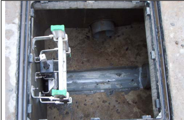
D.O. B avec vanne et by pass
