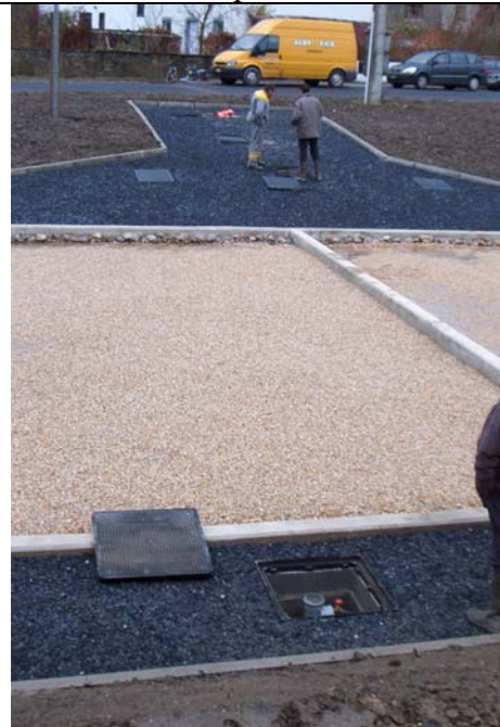
Vue de l'aval d'une cellule emplie de graviers. De l'arrière plan vers l'avant : D.O. A et D.O. B, F.S., Répartiteurs, cellule, regard de sortie)
