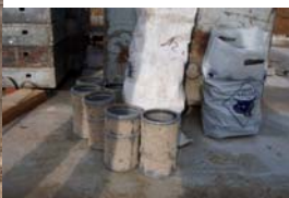
Tuyaux de sortie et d'entrée des eaux dans les cellules. Manchons préparés pour passage dans les parois.
