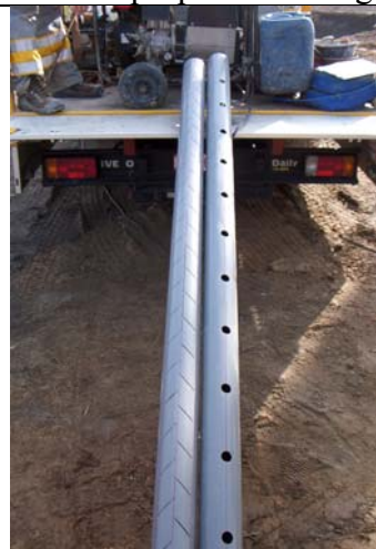
Tuyaux de sortie et d'entrée des eaux dans les cellules. Manchons préparés pour passage dans les parois.
