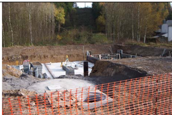
Terrassements effectués. Avant-plan : D.O. et Fosse septique. Bétonnage des cellules
